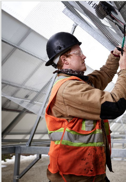
Employé de Solvest installant des panneaux solaires.
