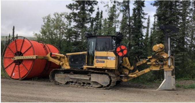
Rétrocaveuse modifiée sur la route Dempster. On s'en sert pour enfouir la conduite dans le sol.
