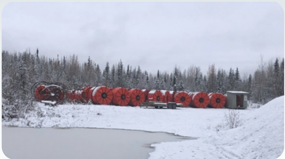
Spools of cable conduit await installation.
