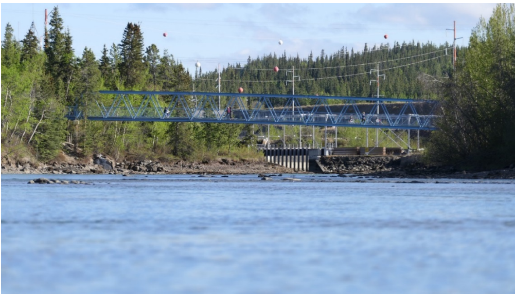
Vue en aval de la centrale hydroélectrique et du pont Rotary Centennial des rapides Whitehorse
