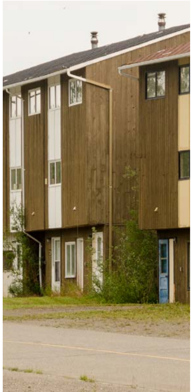
Bâtiments à Faro, au Yukon.
