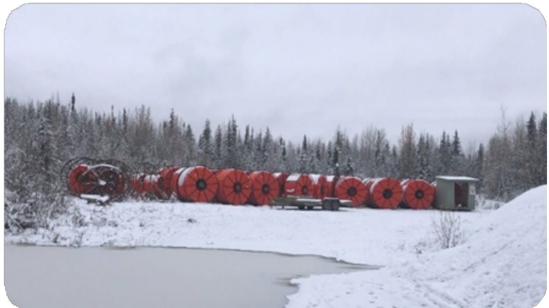
Bobines de gaine de câble qui seront installées.
