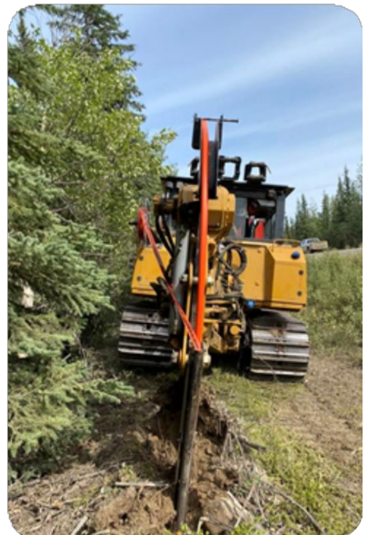
L'engin de chantier en action.
