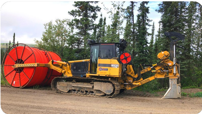
Engin de chantier chargé et prêt à installer la gaine du câble.
