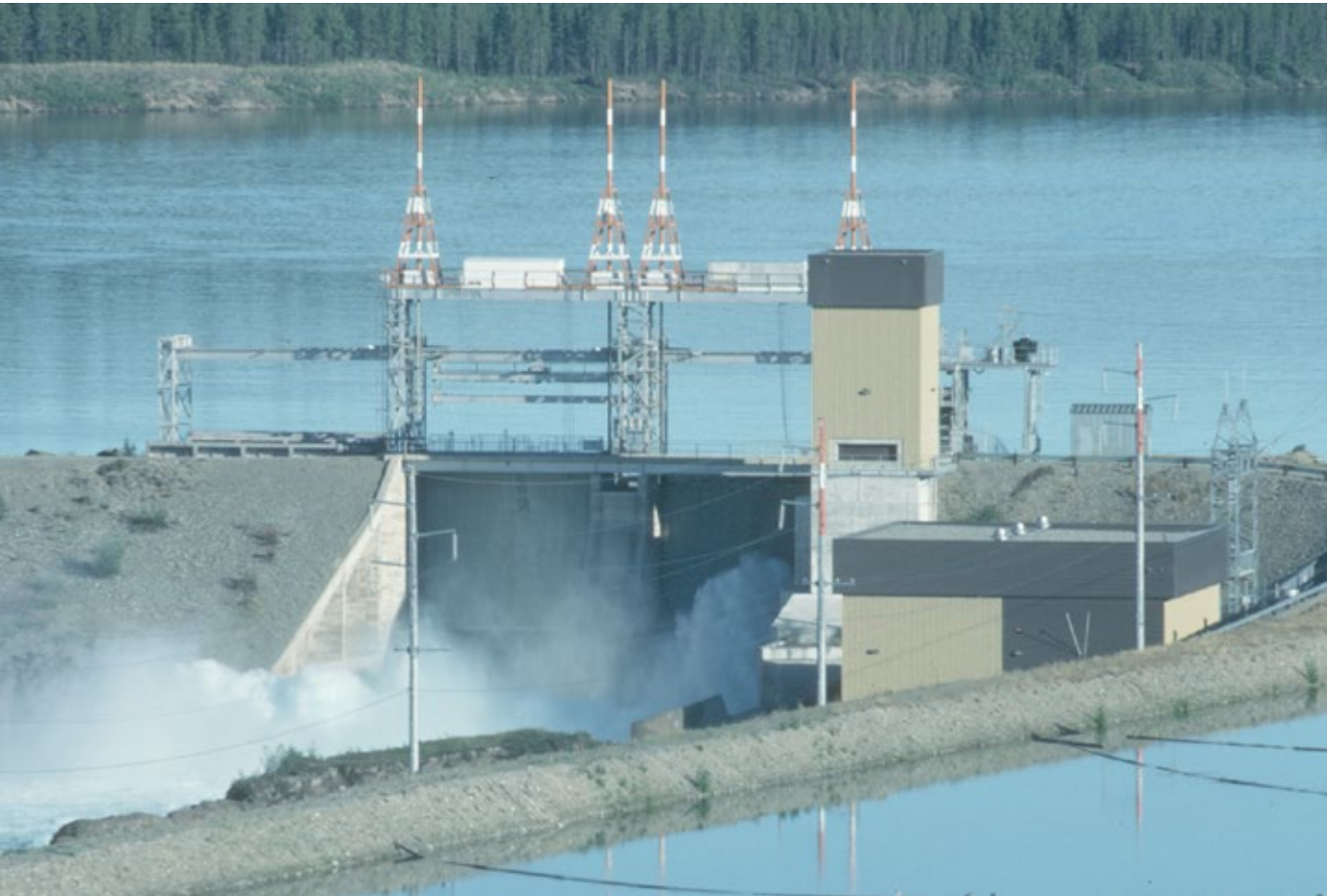
Barrage de Whitehorse, où le réservoir du lac Schwatka coule dans le fleuve Yukon et assure la production d'électricité pour Whitehorse. Gouvernement du Yukon.
